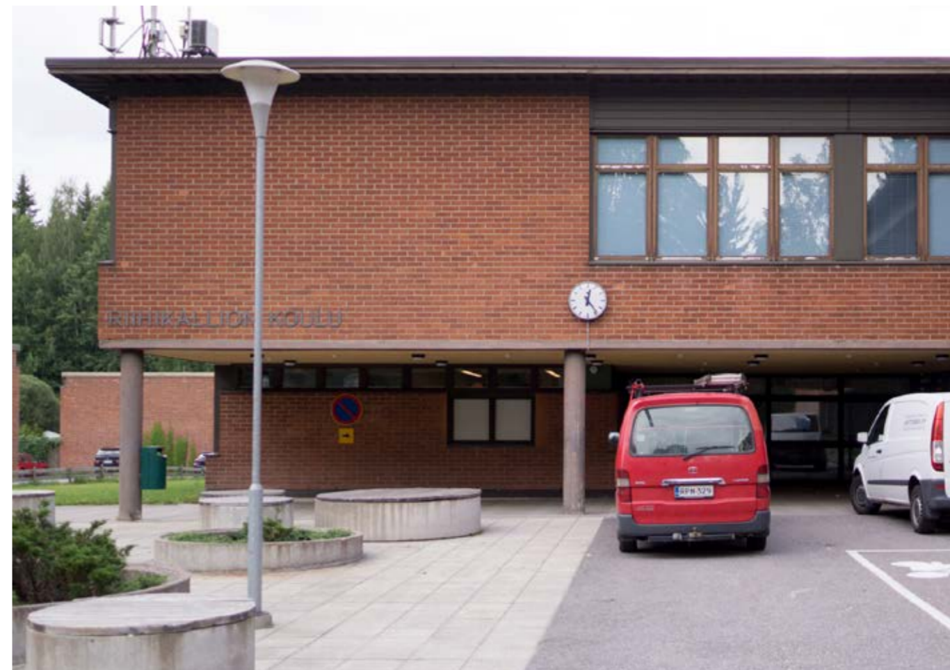
Yllä: Vuoden 1968 osan eteläjulkisivuun lisättiin kaksi uutta ikkunaa 2015.
