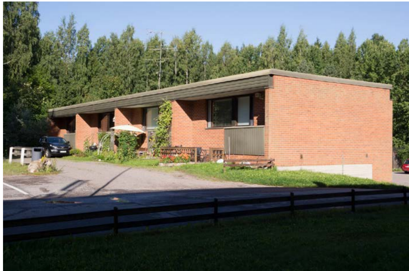
Yllä: Entiset opettajien asunnot, B-talon eteläjulkisivu.
