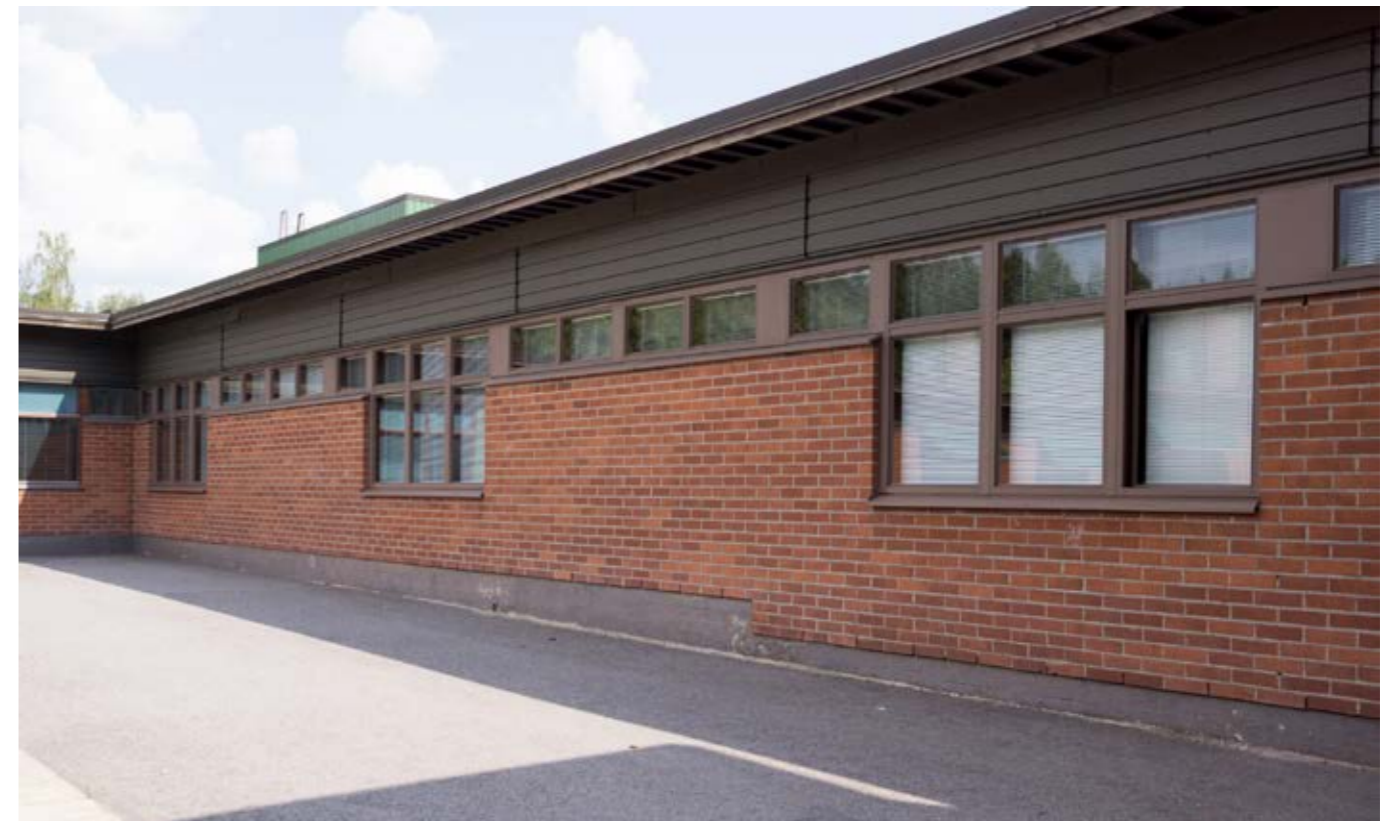
Yllä: Vuoden 1976 laajennuksen julkisivuissa ikkunat ovat pienempiä ja kooltaan vaihtelevampia.
