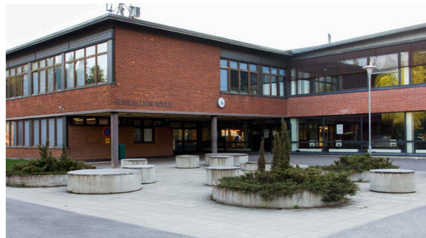
Yllä: Vuoden 1968 osan ja vuoden 2006 laajennuksen liittymäkohta. Tuusulan kunta.
