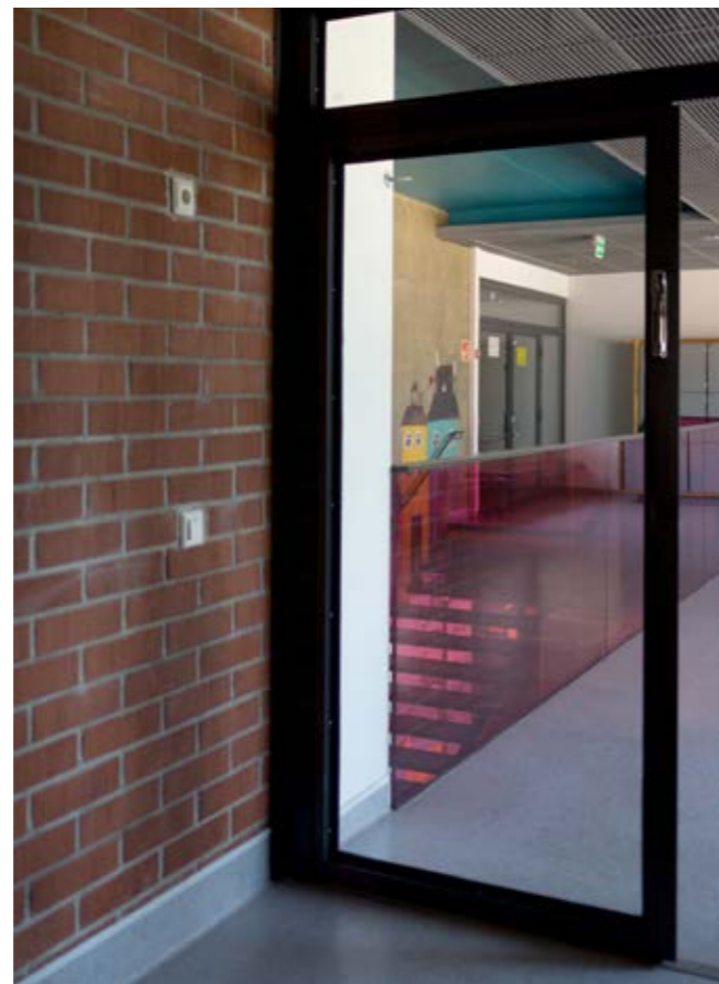
Yllä: Vanhan osan ja laajennuksen liittymäkohta.
