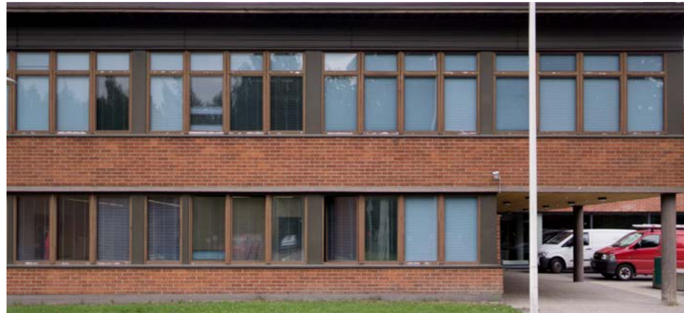
Yllä: Vuoden 1968 osan itäjulkisivu on voimakkaan horisontaalinen.
