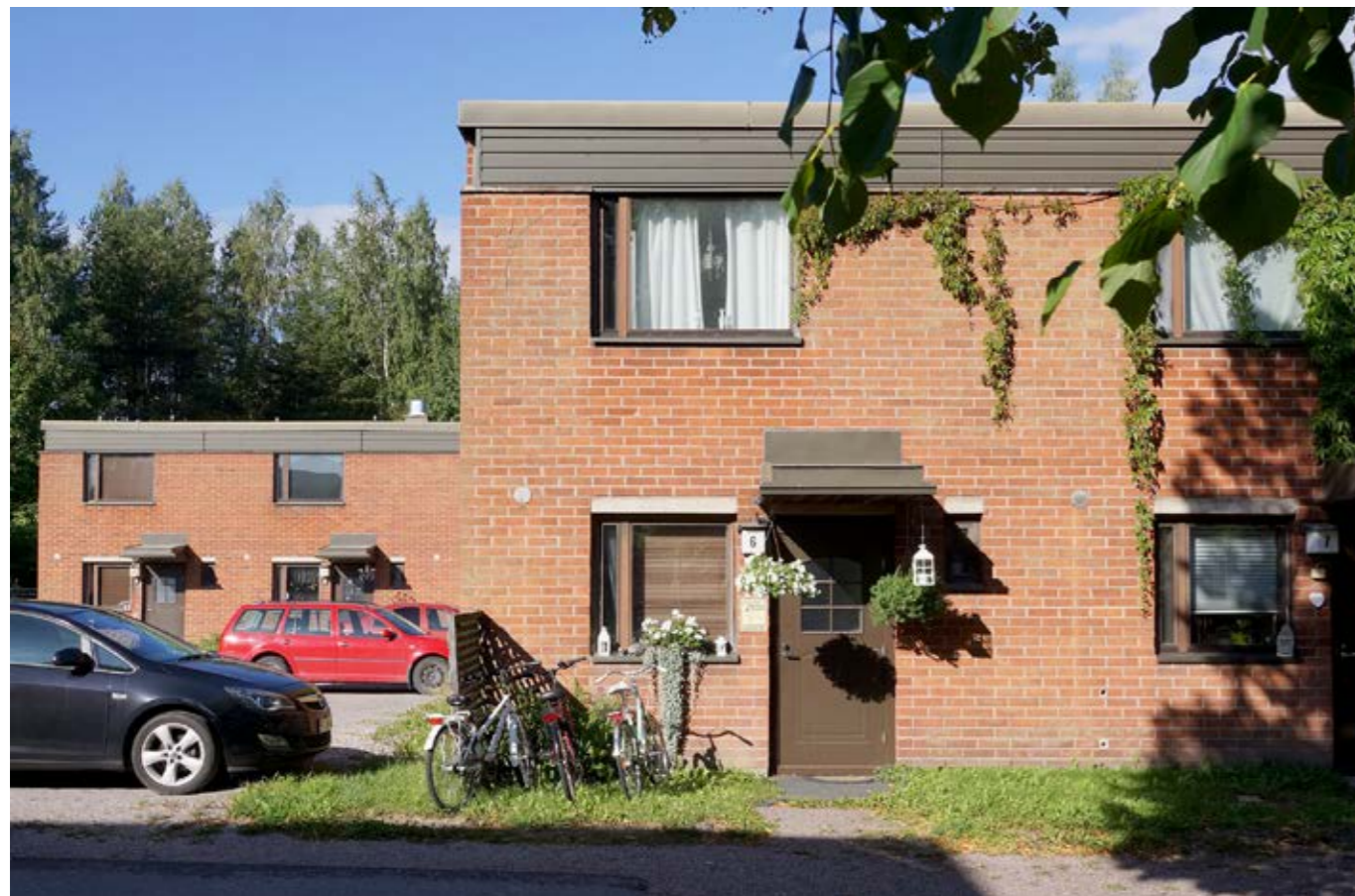
Yllä: C-talon itäjulkisivu.
