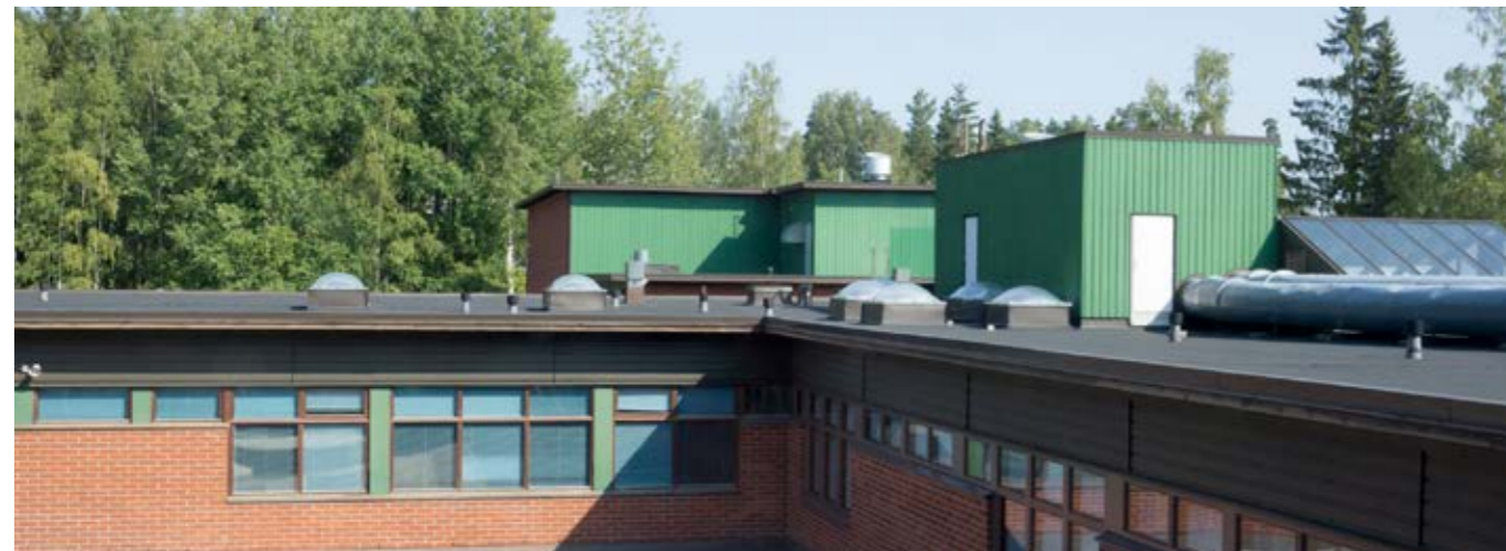
Yllä: IV-konehuonetta laajennettiin ja osa uusista IV-kanavista sijoitettiin katolle vuoden 2004 saneerauksessa.
